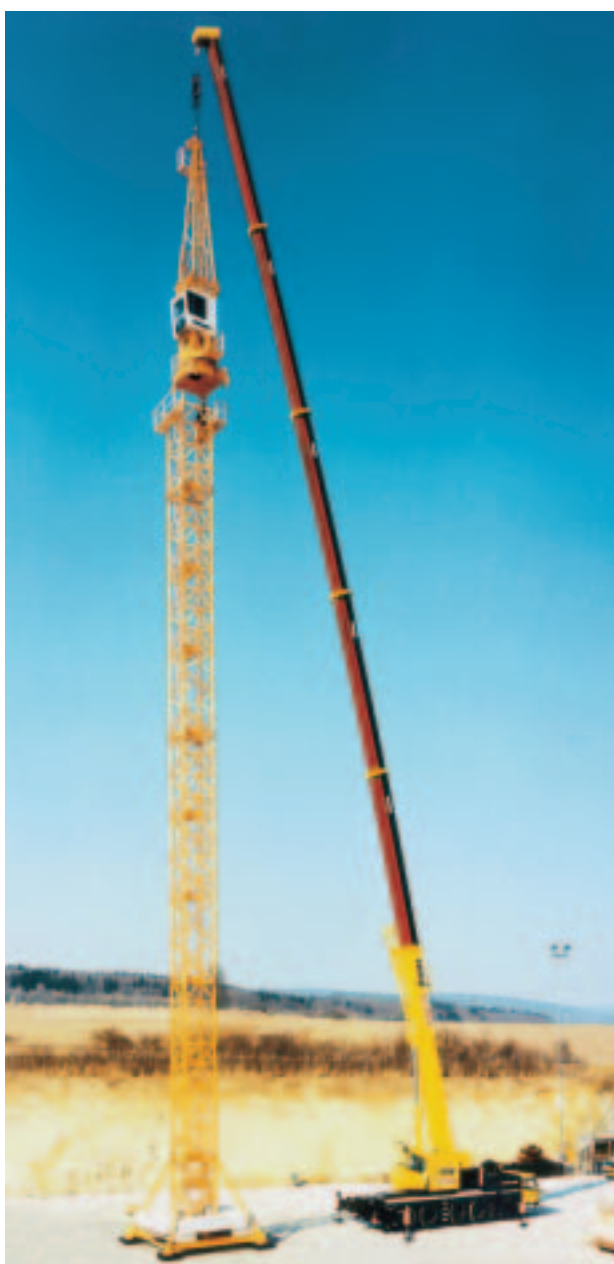
Kuva 23: Liikkuva nosturi rakennusnosturin asennustyössä (kuva julkaistu Liebherr-Werk Ebingen GmbH, Ebingen- -yhtiön luvalla)
