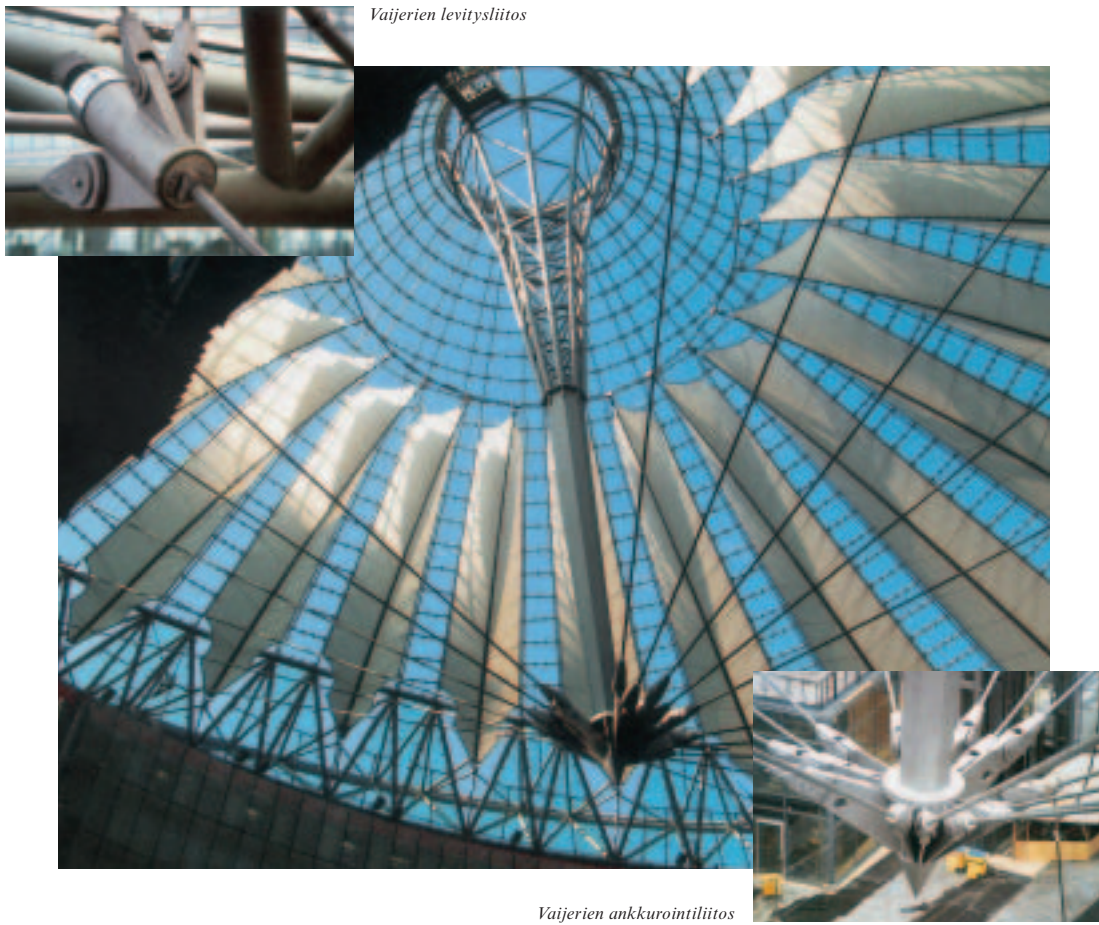
Kuva 18: Berliinin Sony-Centerin kattorakenne, jonka rengaspalkin hahlot sekä vaijerien levitys- ja ankkurointiliitokset ovat DILLIMAX 690 terästä (kuva julkaistu Waagner-Biró AG, Wien, yhtiön luvalla)
